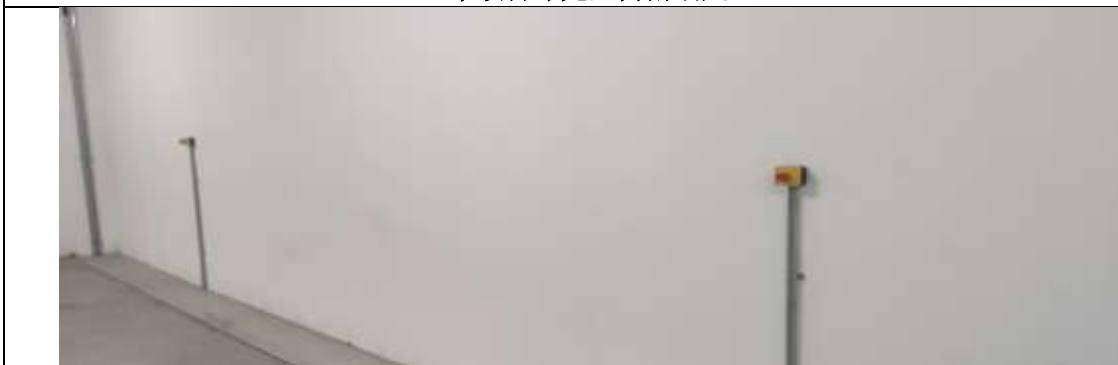
本项目曝光室内东墙处
