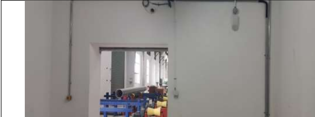
本项目曝光室内南墙处
