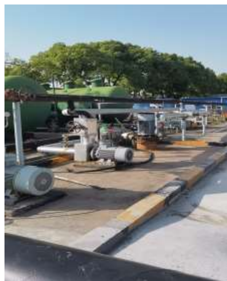
生产废水提升泵站口
