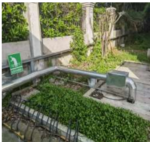
生活污水排放口
